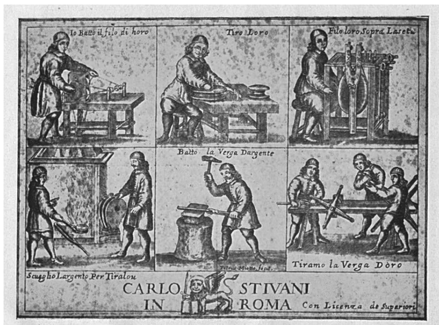
FIGURE 2. Various tira l'oro operations by Carlo Stivani, Rome, ca. 1640. From Luigi Brenni, L'arte del battiloro ed i filati d'oro e d'argento: Cenni storico-tecnici e 18 illustrazioni (Milan: the author, 1930), 48. From left to right, and from top to bottom (in rather improper Italian, even for that time): "I am flattening the gold thread ( Io batto il filo di horo ); I draw the gold ( Tiro loro ); I overspin the gold on the silk ( Filo loro sopra la seta ); I melt the silver for the drawing operation ( Scuaglio l'argento per tiraloro ); I hammer the silver bar ( Batto la verga d'argente ); we draw the gold bar ( Tiramo la verga d'oro )."
